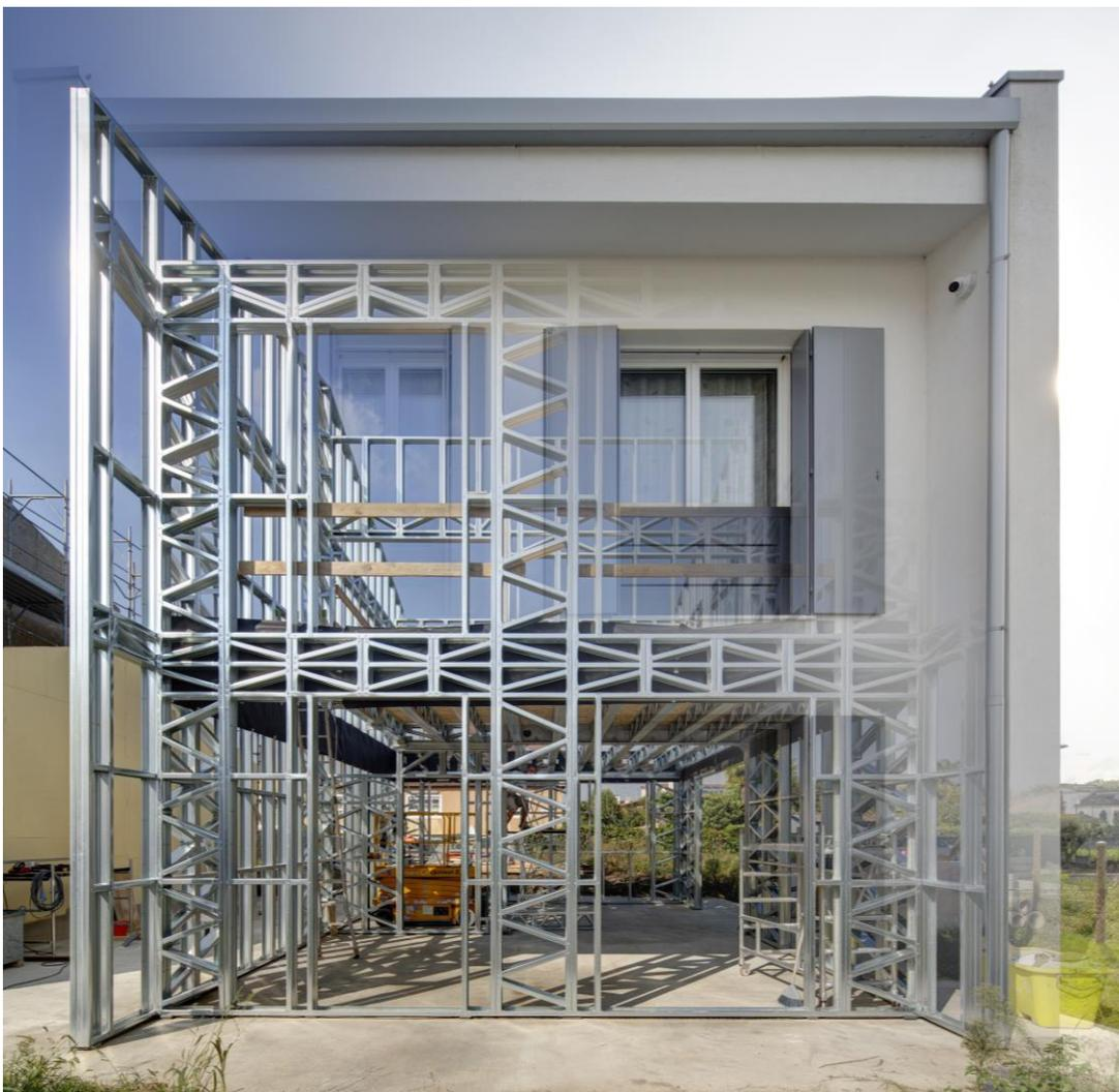
La struttura a profilo aperto fa parte di uno dei Moderni Metodi di Costruzione alla cui base c'è il rivoluzionario procedimento Light Steel Framing (LSF), identificante una piegatura a freddo di nastri sottili di spessore variabile (10/10 di mm, 12/10 di mm.) di lamiera in acciaio zincato laminata a caldo.
